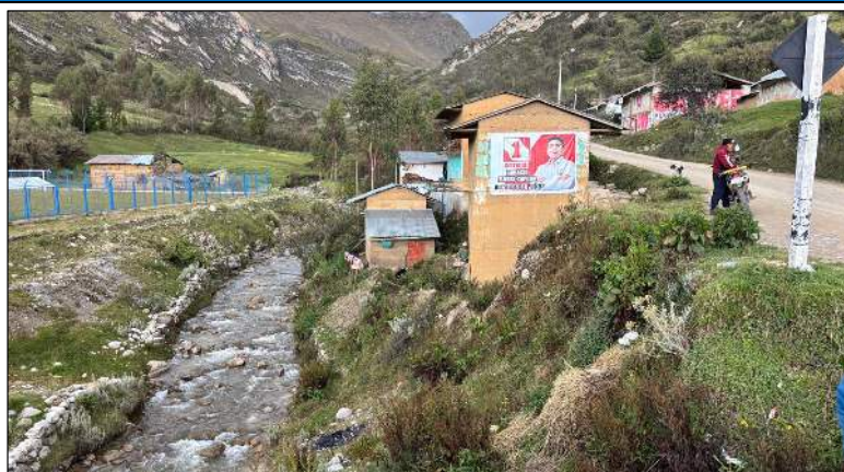
Figura 1. Vista general del tramo evaluado de la quebrada Poque (Achcayragra), mostrando la configuración del cauce y entorno poblado. Evidencia del ancho aproximado de 6 metros y condiciones del flujo.
