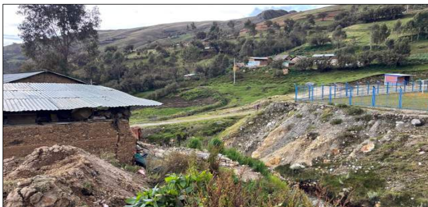
Figura 2. Riesgo inminente de colapso de viviendas por erosión. Condición crítica generada por la cercanía al flujo y la inestabilidad del terreno. Degradación de cobertura vegetal protectora. Pérdida de vegetación que incrementa la vulnerabilidad del terreno. Sector con mayor nivel de riesgo para la población e infraestructura.
